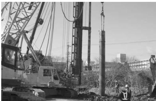
3号館（新棟）の杭打ちを行っています。建物をしっかり確実に支持するため、長さ37メートルの杭を地中に打設します。
