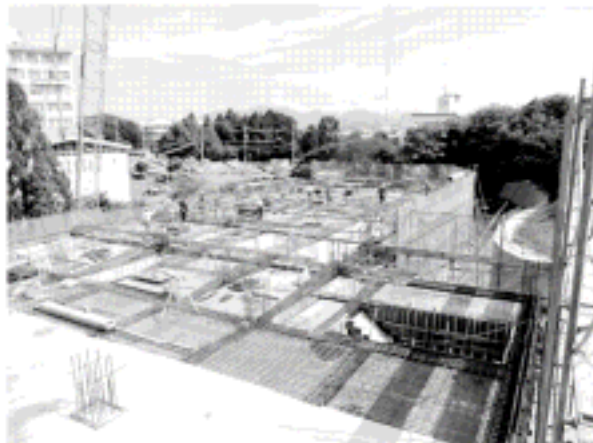
建物躯体（鉄筋コンクリート）工事が進んでいます。
