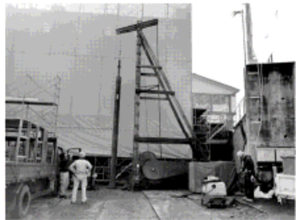
井戸を掘削している様子です。災害時のライフラインを確保するため、市水・地下水の両方を使えるように整備します。
