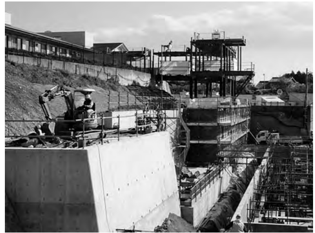
2号館（現北棟）と接続する渡り廊下の工事を行っています。（写真奥）
