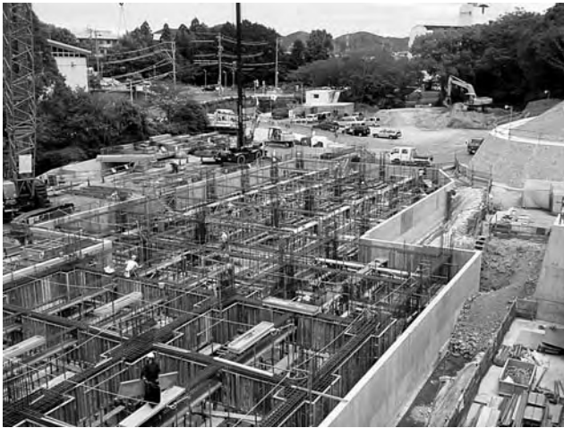
いよいよ建物躯体（鉄筋コンクリート）工事に着手しました。1階床部分の工事を行っています。
