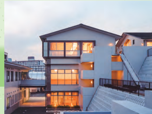
〈エレベーター棟〉
