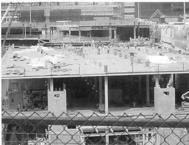
地下の再開発が急ピッチで進んでいる。
