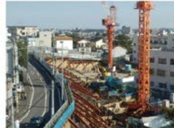
組立工事 開始
