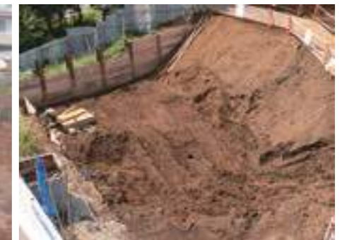
土留め工事風景
