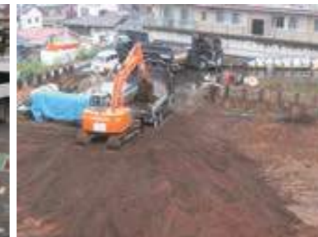
土の撤去作業風景
