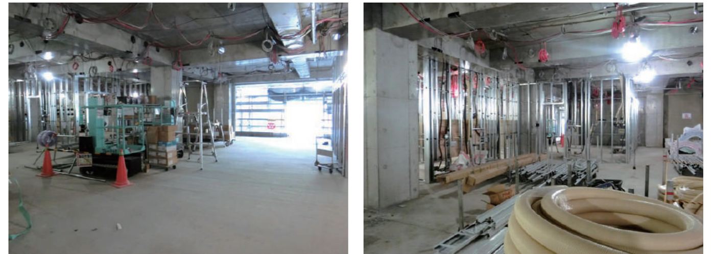
A棟 2階内部 工事写真
