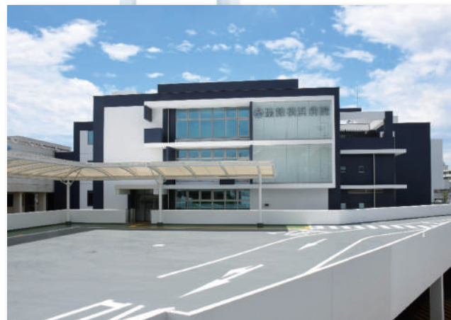
2019年7月16日にA棟(新外来棟)の稼働開始
